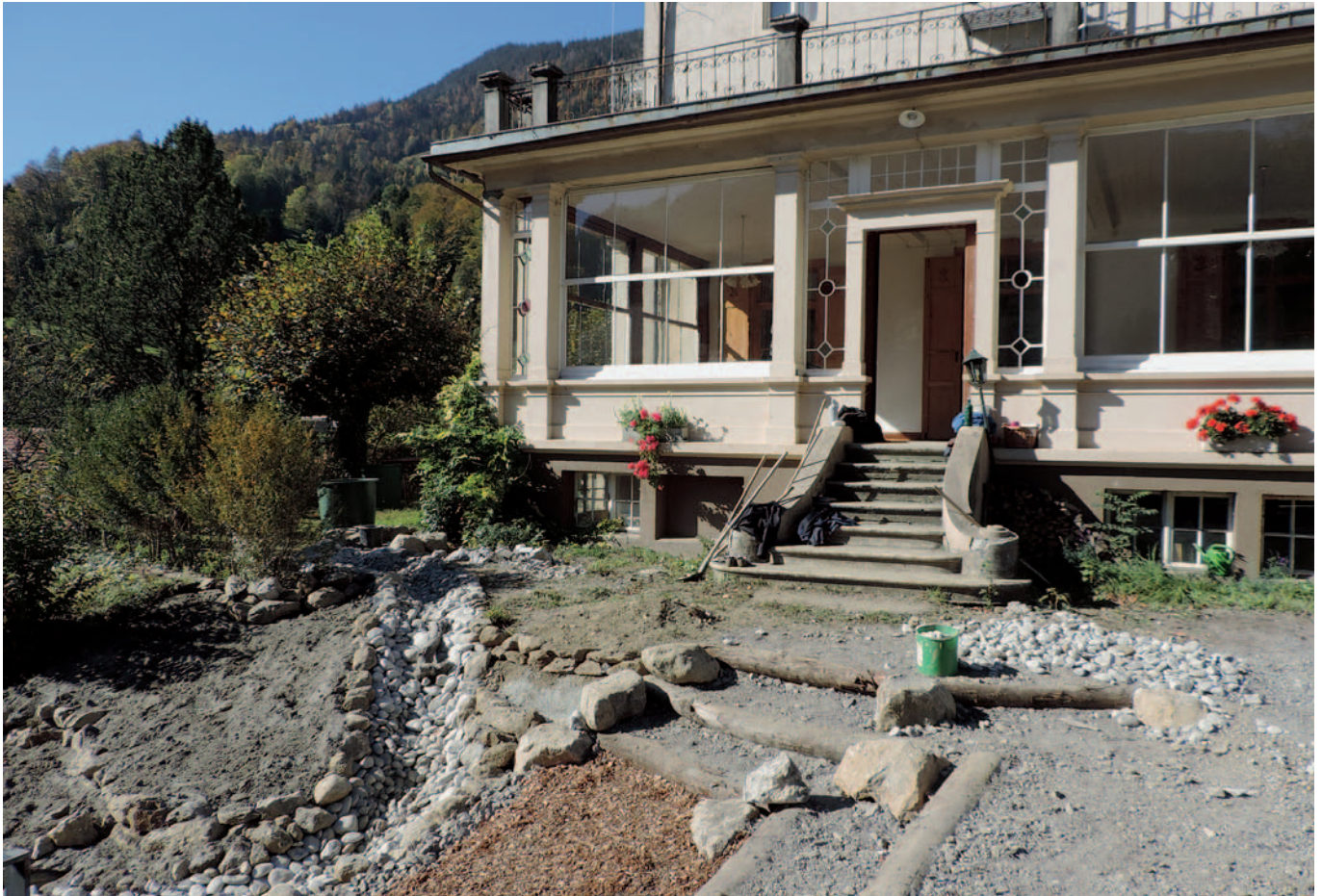
Hoteleingang mit Permakulturanlage im Entstehen
